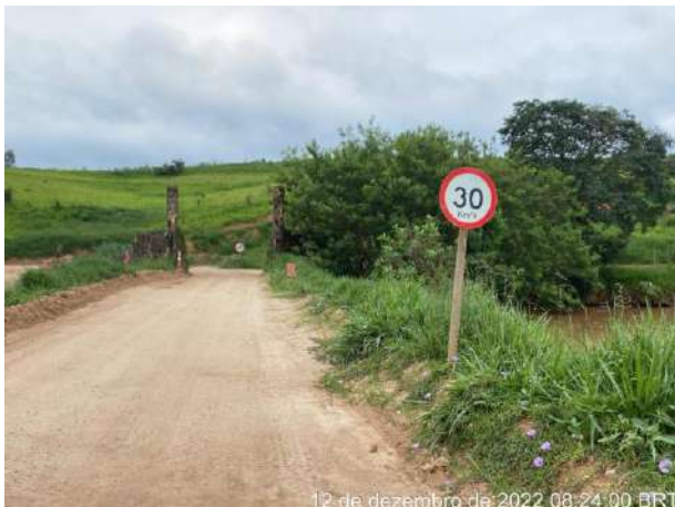
Foto 135 – Sinalização de acesso interno da obra. (Data: 12/12/2022)
