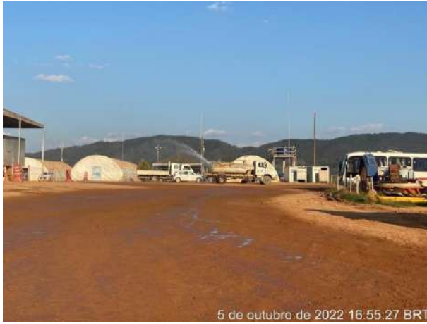
Foto 214 – Umectação de vias interna. (Data:05/10/2022)
