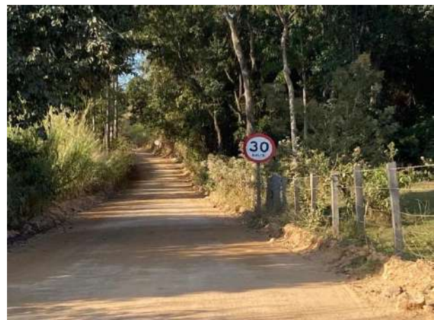
Foto 130 – Sinalização na via municipal de acesso à obra. (Data: 15/11/2022)
