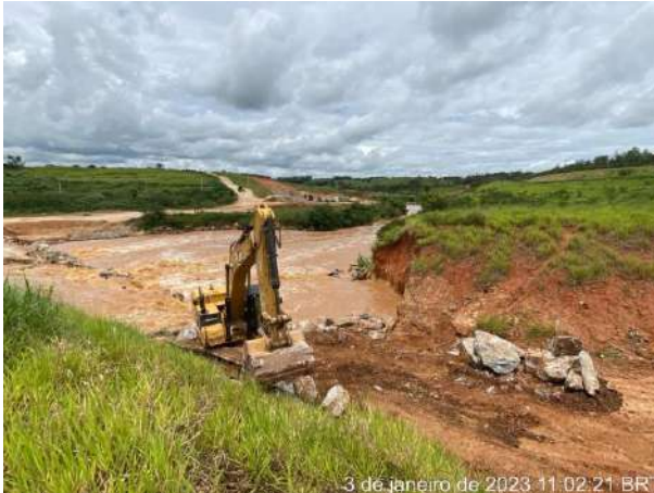
Foto 265 – Manutenção da passagem molhada. (Data:03/01/2023)
