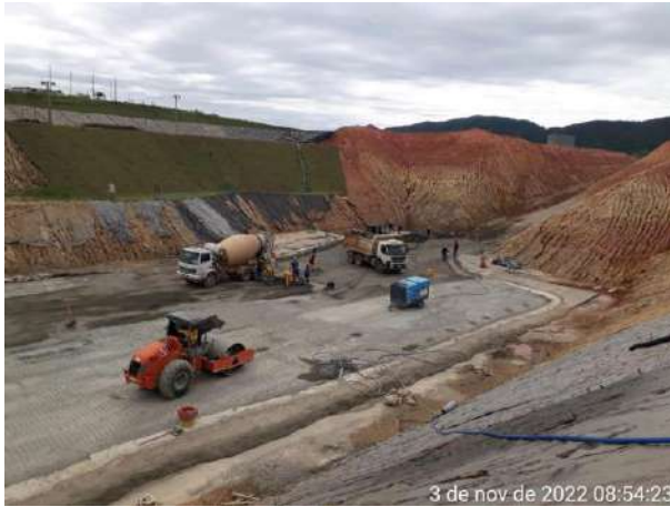
Foto 193 – Canaletas de drenagem definitiva. (Data:03/11/2022)
