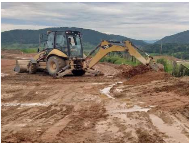
Foto 263 – Movimentação de terra. (Data:17/10/2022)
