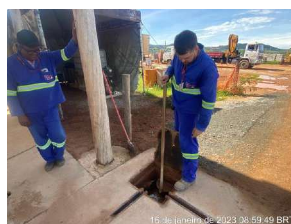
Foto 209 - Vistoria da caixa de inspeção. (Data: 16/01/2023)
