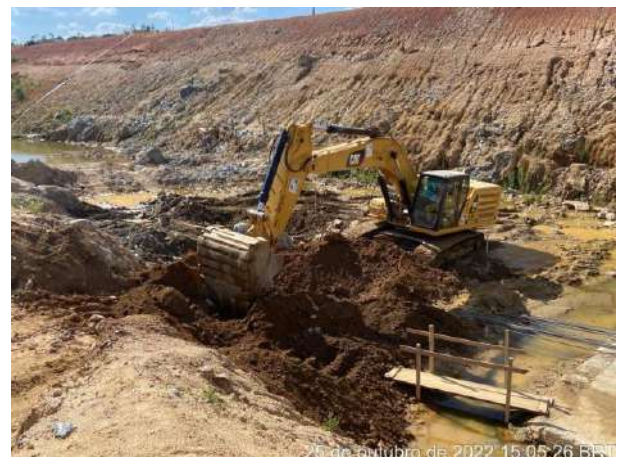
Foto 264 – Movimentação de terra. (Data: 25/10/2022)
