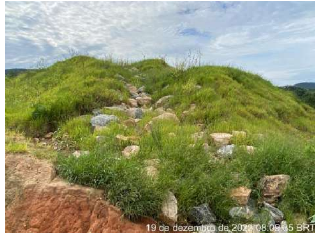
Foto 185 – Enrocamento com disciplinamento do fluxo para as caixas de retenção (Data: 19/12/2022)
