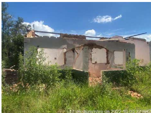
Foto 253 – Demolição da estrutura 29 B, lote 23. (Data:17/12/2022)
