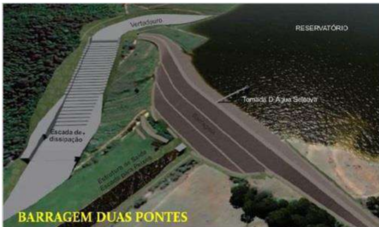
Figura 1 – Projeção da futura Barragem Duas Pontes
