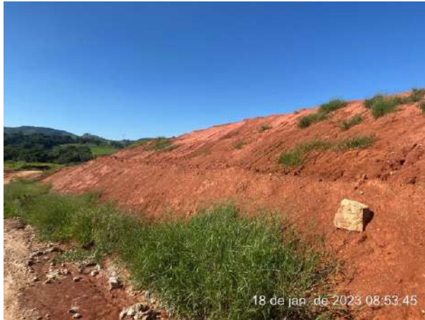
Foto 156 – Leira de proteção no entorno do bota espera com inclinação para a saída do talude. (Data: 18/01/2023)
