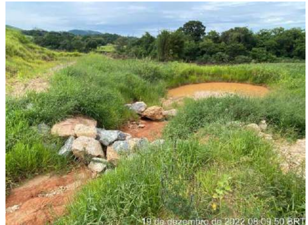
Foto 187 – Vista para as caixas de retenção. (Data: 19/12/2022)
