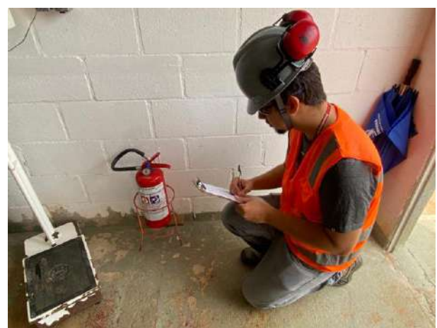
Foto 104 - Inspeção de extintor realizado por auxiliar de segurança . (Data: 23/11/2022)
