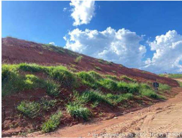
Foto 150 – Leira de proteção no entorno do bota espera com inclinação para a saída do talude. (Data: 07/12/2022)
