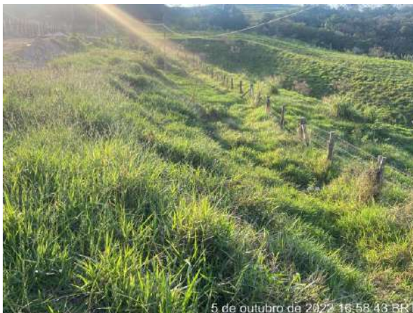
Foto 200 – Leira e gramíneas e disciplinamento de águas pluviais. (Data:05/10/2022)
