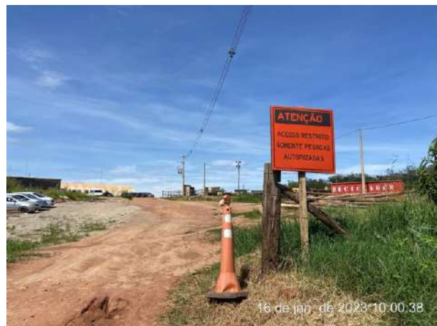
Foto 136 – Sinalização de acesso interno da obra. (Data: 16/01/2023)
