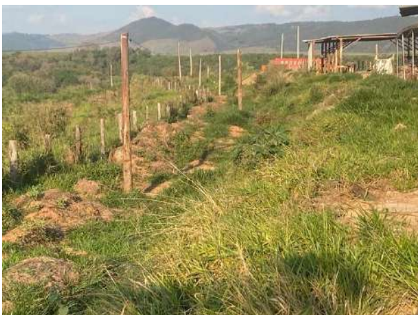
Foto 202 – Leira e gramíneas e disciplinamento de águas pluviais. (Data:15/12/2022)
