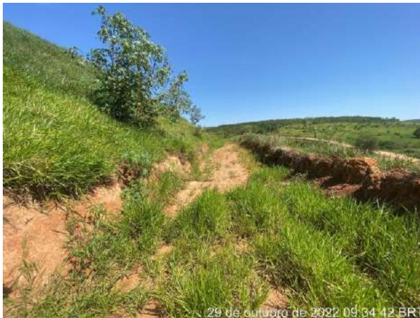
Foto 165 – Leira de proteção no entorno. Bota Fora 01. (Data: 29/10/2022)
