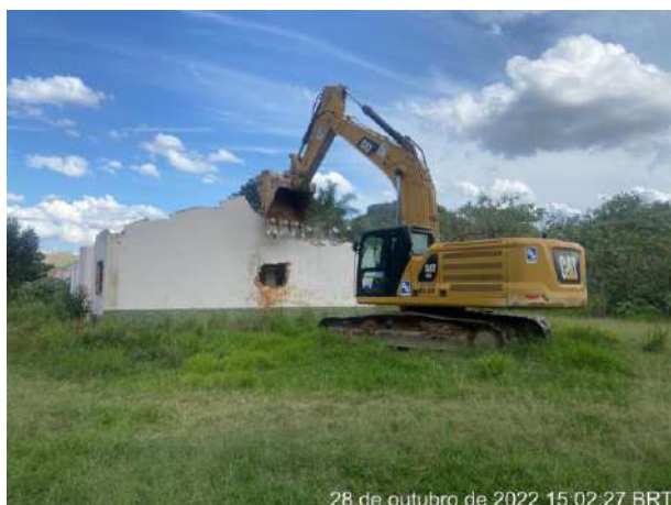
Foto 245 – Demolição da estrutura 29 A, lote 23. (Data:28/10/2022)
