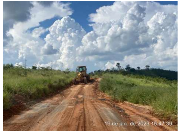
Foto 268 – Movimentação de terra, margem esquerda. (Data:10/01/2023)
