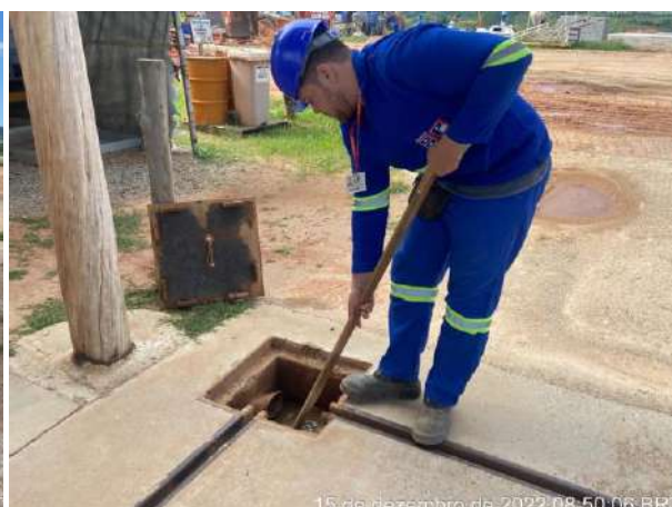
Foto 207 - Vistoria da caixa SAO. (Data: 15/12/2022)
