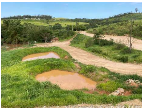
Foto 182 – Cacimba de retenção de sedimento. (Data: 28/11/2022)
