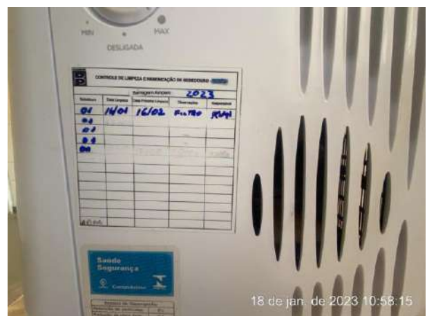
Foto 102 – Registro de limpeza interna e externa do bebedouro. (Data:18/01/2023)
