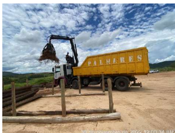
Foto 234 – Troca de caçambas de resíduo de metal da margem direita. (Data:30/11/2022)
