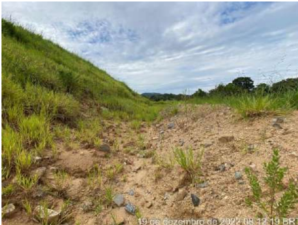
Foto 186 – Disciplinamento do fluxo para as caixas de retenção. (Data:19/12/2022)
