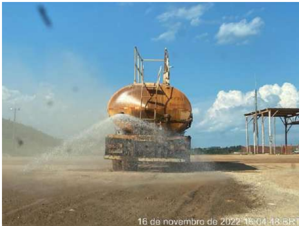
Foto 216 – Umectação de vias interna. (Data:16/11/2022)
