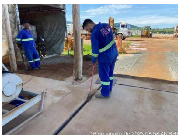
Foto 208 –Limpeza das canaletas na área de abastecimento de combustível. (Data: 16/01/2023)
