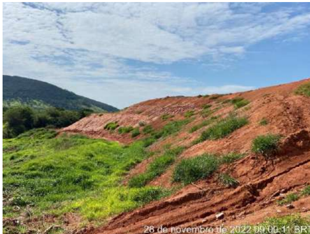
Foto 144 – Leira de proteção no entorno do bota espera com inclinação para a saia do talude. (Data: 28/11/2022)
