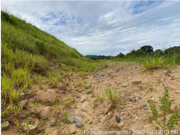
Foto 184 – Disciplinamento do fluxo para as caixas de retenção. (Data: 19/12/2022)
