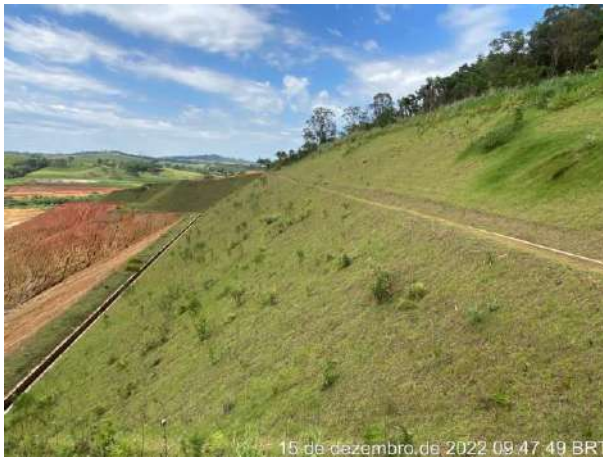
Foto 195 – Canaletas de drenagem definitiva. (Data:15/12/2022)
