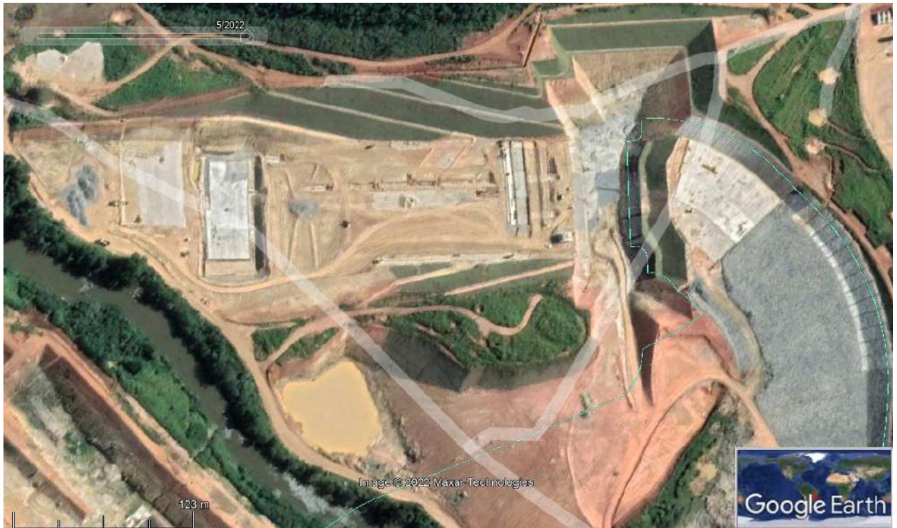
Foto 190 – Margem Direita - Vertedouro. (Ilustrativo)
