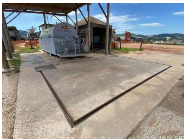
Foto 206 – Canaletas da área de abastecimento limpas. (Data: 15/12/2022)
