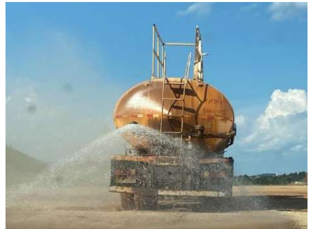
Foto 221 – Umectação de vias internas. (Data: 15/01/2023)
