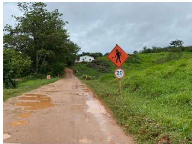
Foto 134 – Sinalização de acesso interno da obra. (Data: 29/11/2022)
