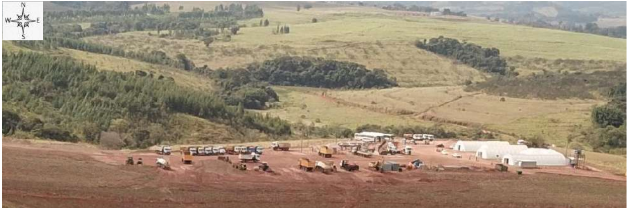
Foto 199 – Canteiro industrial. (Ilustrativo)
