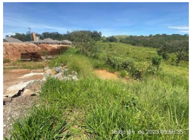
Foto 203 – Leira e gramíneas e disciplinamento de águas pluviais. (Data:16/01/2023)
