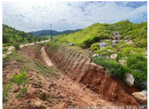
Foto 181 – Disciplinamento do fluxo para as caixas de retenção. (Data: 28/11/2022)
