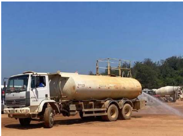
Foto 218 – Umectação de vias interna. (Data:08/12/2022)
