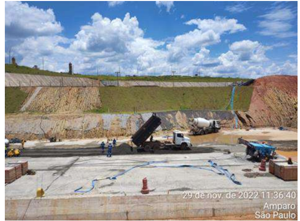
Foto 194 – Grama e canaleta de drenagem. (Data:29/11/2022)
