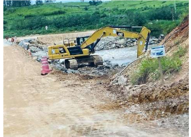
Foto 266 – Manutenção do enrocamento da passagem molhada. (Data:06/01/2023)
