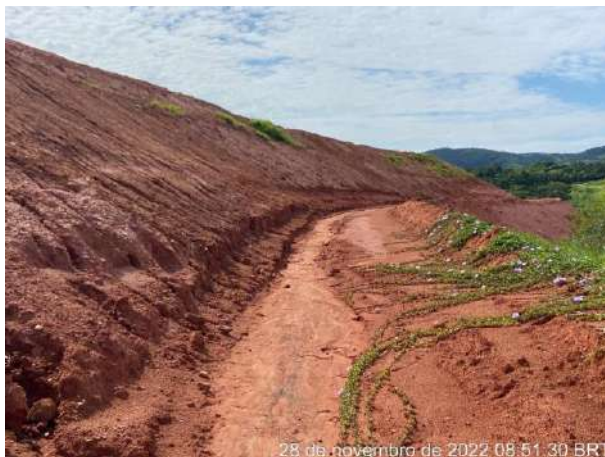
Foto 146 – Vista para leira e inclinação e direcionamento para saia do talude. (Data:28/11/2022)
