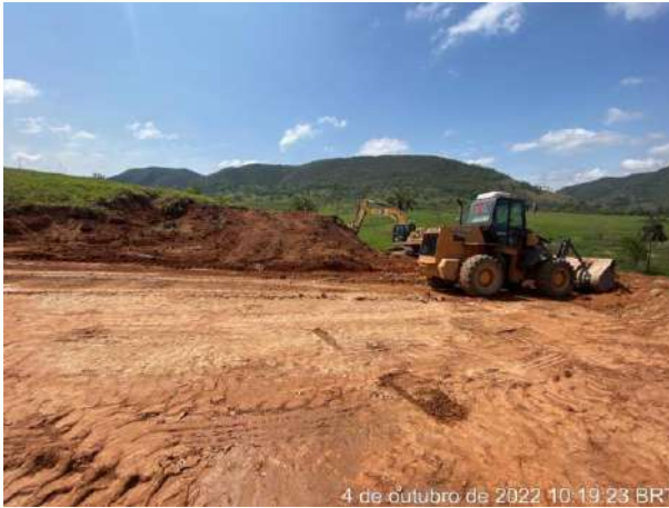
Foto 259 – Movimentação de terra, margem direita. (Data:04/10/2022)
