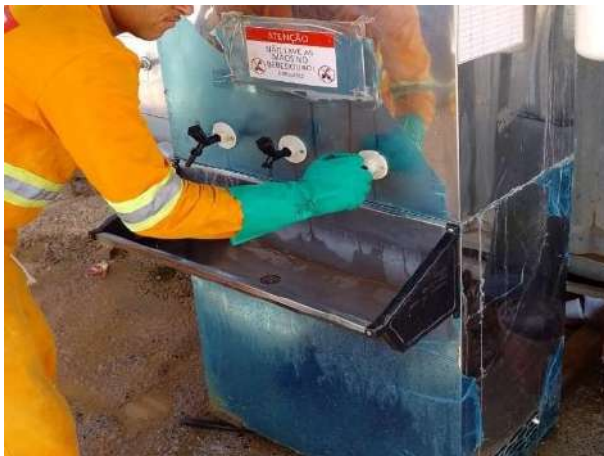
Foto 99 – Limpeza externa do bebedouro da margem direita. (Data:16/01/2023)
