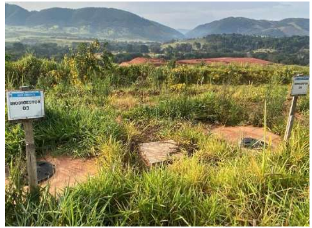
Foto 211 – Biodigestores do canteiro industrial. (Data: 27/11/2022)
