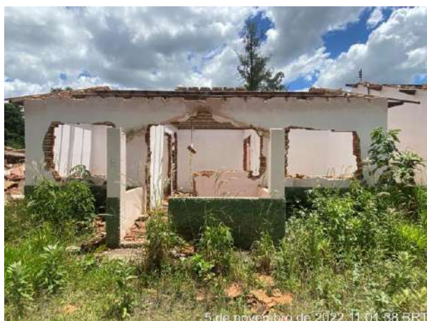
Foto 249 – Demolição da estrutura 29 B, lote 23. (Data:05/11/2022)
