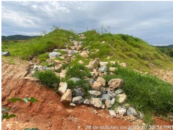
Foto 178 – Enrocamento com disciplinamento do fluxo para as caixas de retenção. (Data: 28/10/2022)
