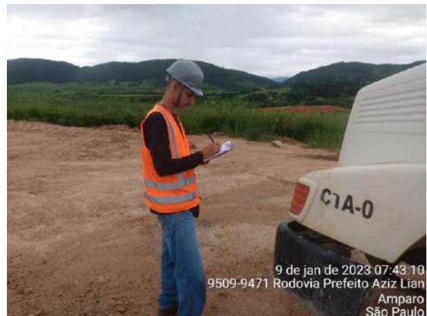
Foto 108 – Inspeção de equipamento realizado por auxiliar de segurança. (Data: 09/01/2023)
