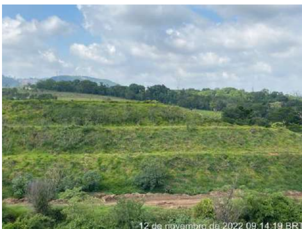
Foto 167 – Vista da cobertura vegetal nos taludes do Bota Fora 01. (Data: 12/11/2022)
