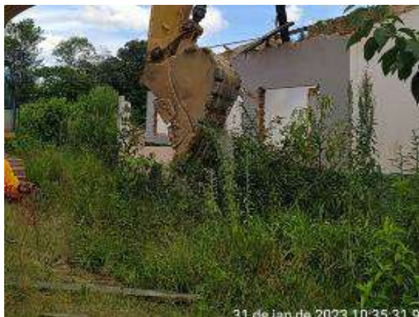
Foto 257 – Demolição da estrutura 29 D e E, lote 23. (Data:31/01/2023)
