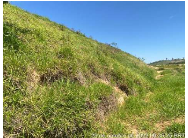
Foto 166 – Vista cobertura vegetal. Bota Fora 01. (Data: 29/10/2022)
