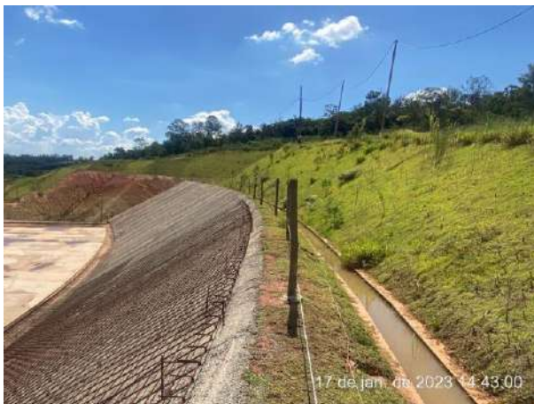
Foto 197 – Canaletas de drenagem definitiva. (Data:17/01/2023)
