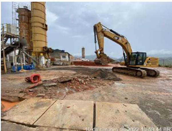
Foto 261 – Movimentação de terra, margem direita. (Data:10/10/2022)
