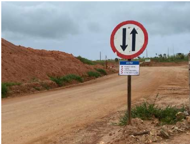
Foto 133 – Sinalização de acesso interno da obra. (Data: 13/10/2022)
