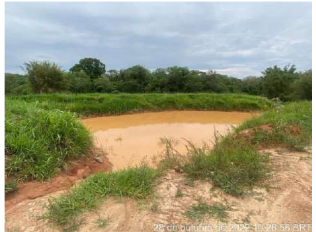
Foto 179 – Cacimba de retenção de sedimento (Data: 28/10/2022)
