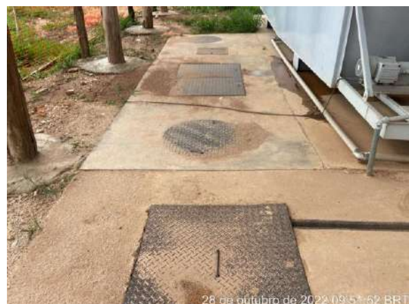
Foto 205 - Vistoria da caixa SAO. (Data: 28/10/2022)
