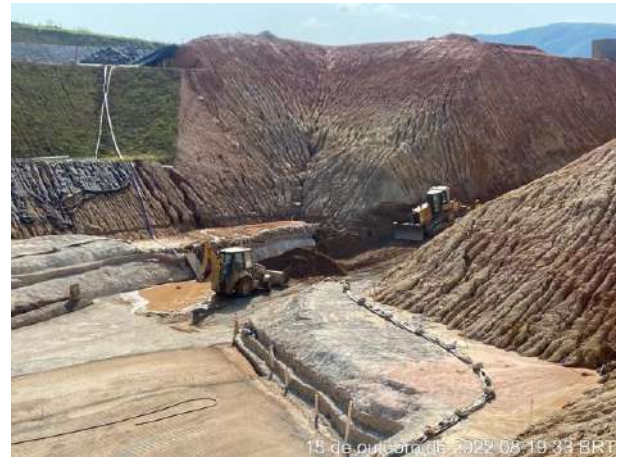
Foto 262 – Movimentação de terra, margem direita. (Data:15/10/2022)
