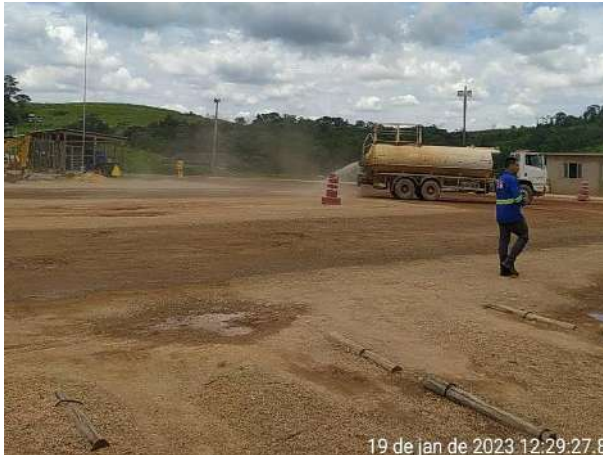
Foto 220 – Umectação de vias interna. (Data:19/01/2023)
