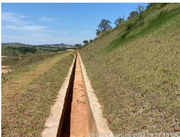
Foto 191 – Canaletas de drenagem definitiva. (Data:29/10/2022)
