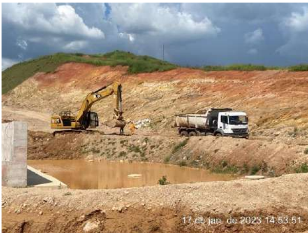
Foto 267 – Movimentação de terra, margem direita. (Data:17/01/2023)
