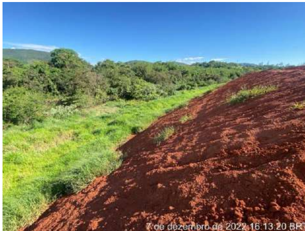
Foto 152 – Vista para leira e inclinação e direcionamento para saída do talude. (Data:07/12/2022)
