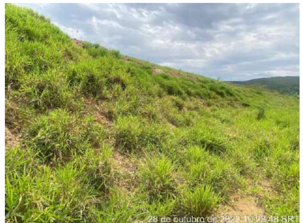
Foto 177 – Cobertura vegetal. (Data: 28/10/2022)
