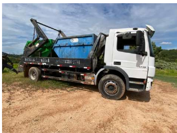
Foto 237 – Troca de caçambas de resíduo comum do canteiro industrial. (Data:16/12/2022)
